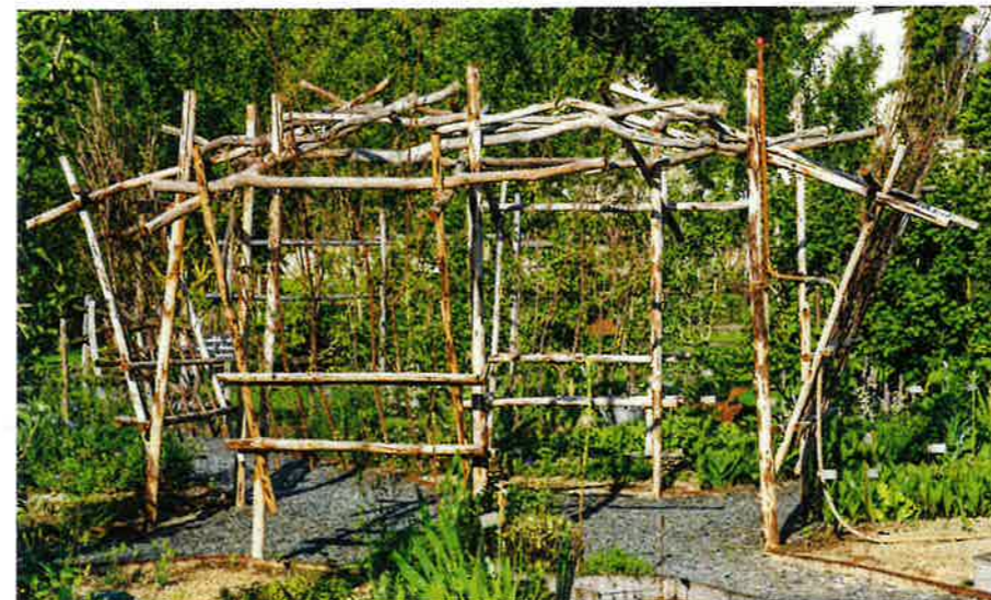
Cette nouvelle construction vient d'être réalisée par les jardiniers. Les armatures sont faites avec des branches d'acacia et de noisetier morts, simplement écorcés. L'idée serait d'y faire grimper des melons reposant sur les parties inclinées.
